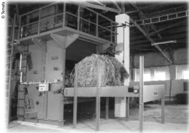
INSTALLATION POUR OUVRIR LES BALLES
