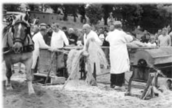
Les travaux sur le bord de Loire
