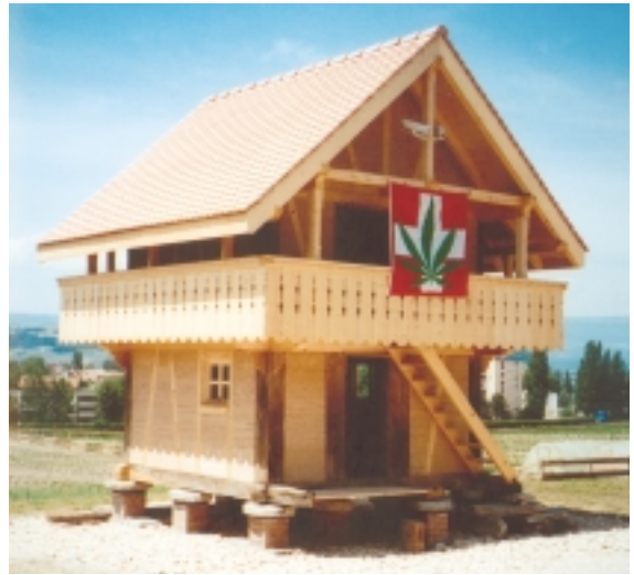
CONSTRUCTION EN CHANVRE ET OSSATURE BOIS.
